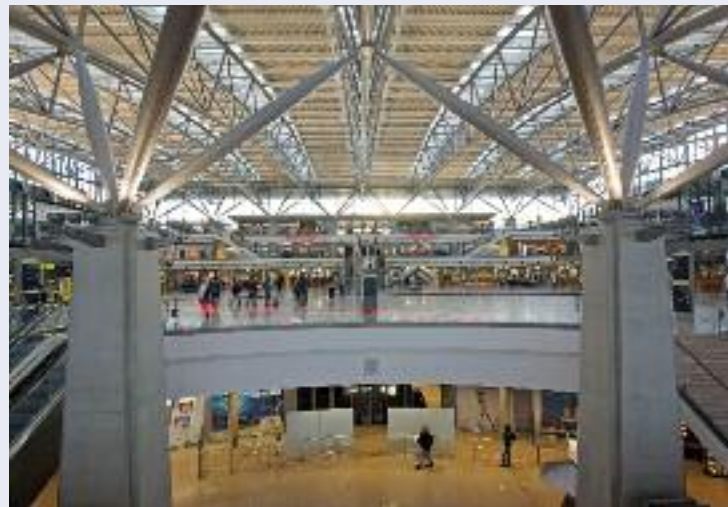
Der Bau neuer Gebäude kennzeichnete die letzten Jahre
