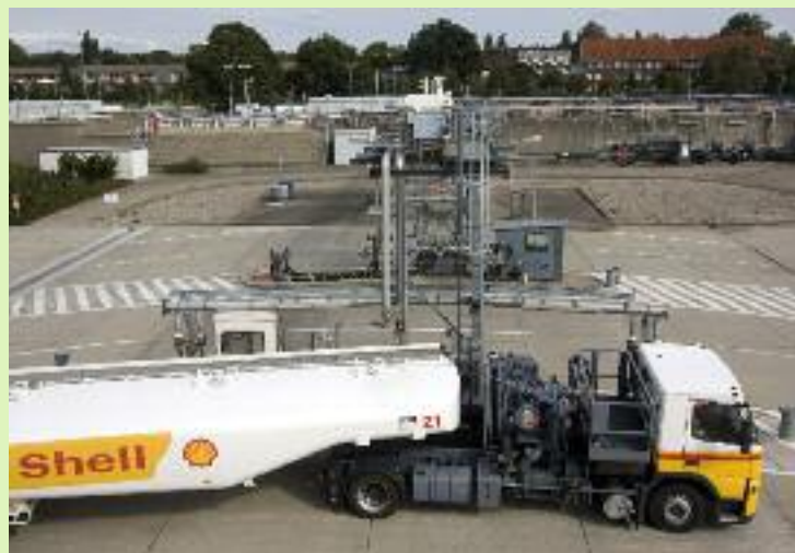
Das Tanklager erfüllt alle Sicherheitsstandards
